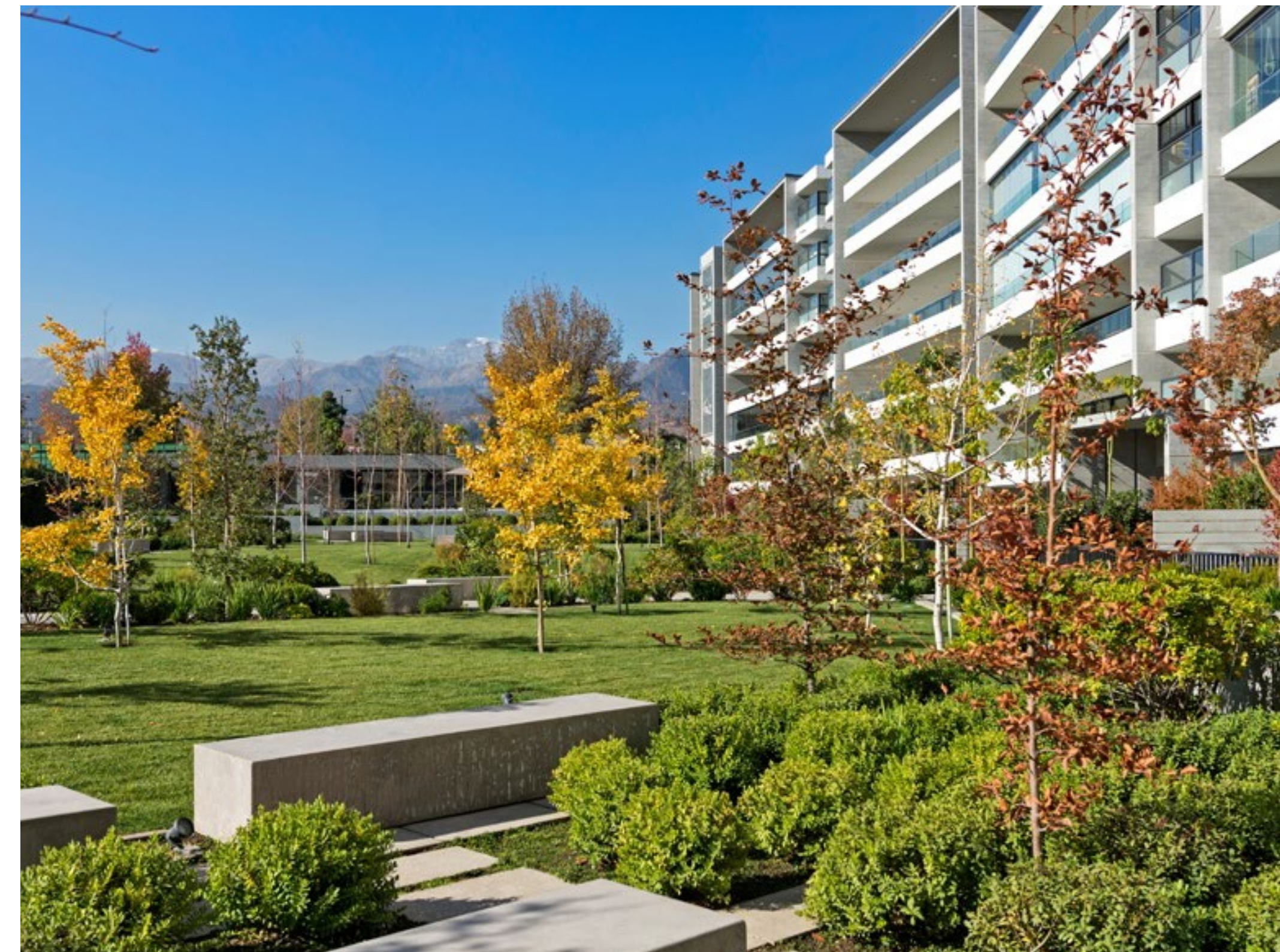
Edificio Verdece I, Lo Barnechea, Chile.
